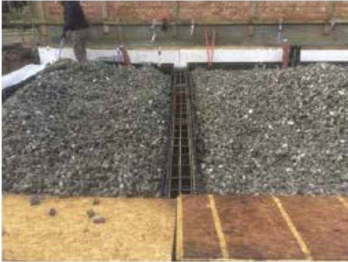
Gerecycleerde grasgranulaten tussen funderingsbalken
