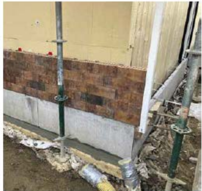
Detail opbouw hoek voor- en zijgevel met gerecupereerde plint en ClickBrick
